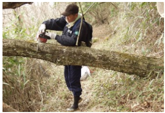
遊歩道の整備
